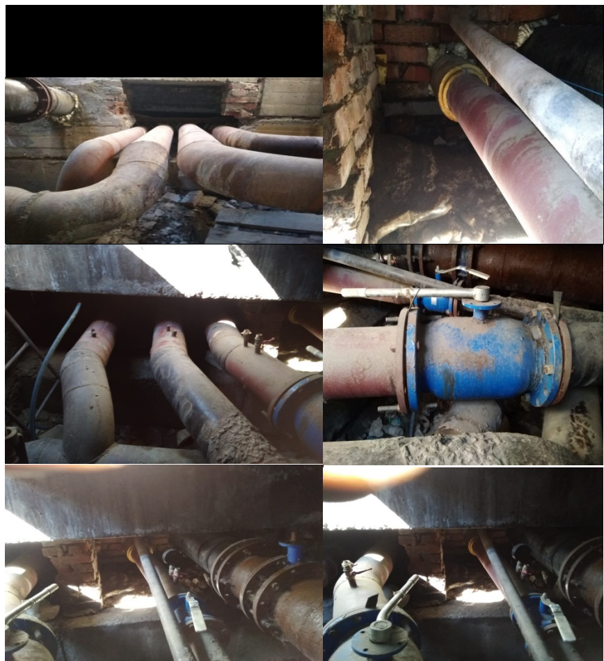
Участок сетей заменен в недавнем времени, состояние трубопроводов и запорной арматуры удовлетворительное
